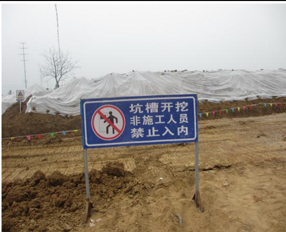
施工期覆盖防尘网
