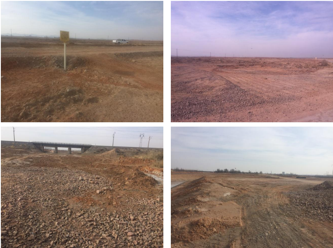
临时占地恢复情况
